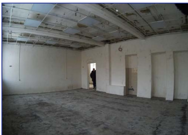
Учебный кабинет. Совсем немного осталось до окончания ремонта... Потолочное покрытие и полы.
